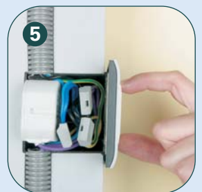
5 Einbau des Aktors in Schalterdose mit Funktafter als Kombinationslösung
