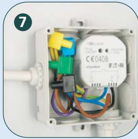
7 Einbau des Aktors in Feuchtraumdose
