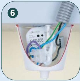
6 Einbau des Aktors in Lampenabdeckung
