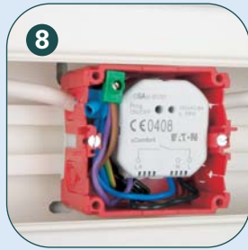
8 Einbau des Aktors in Kabelkanaldose
