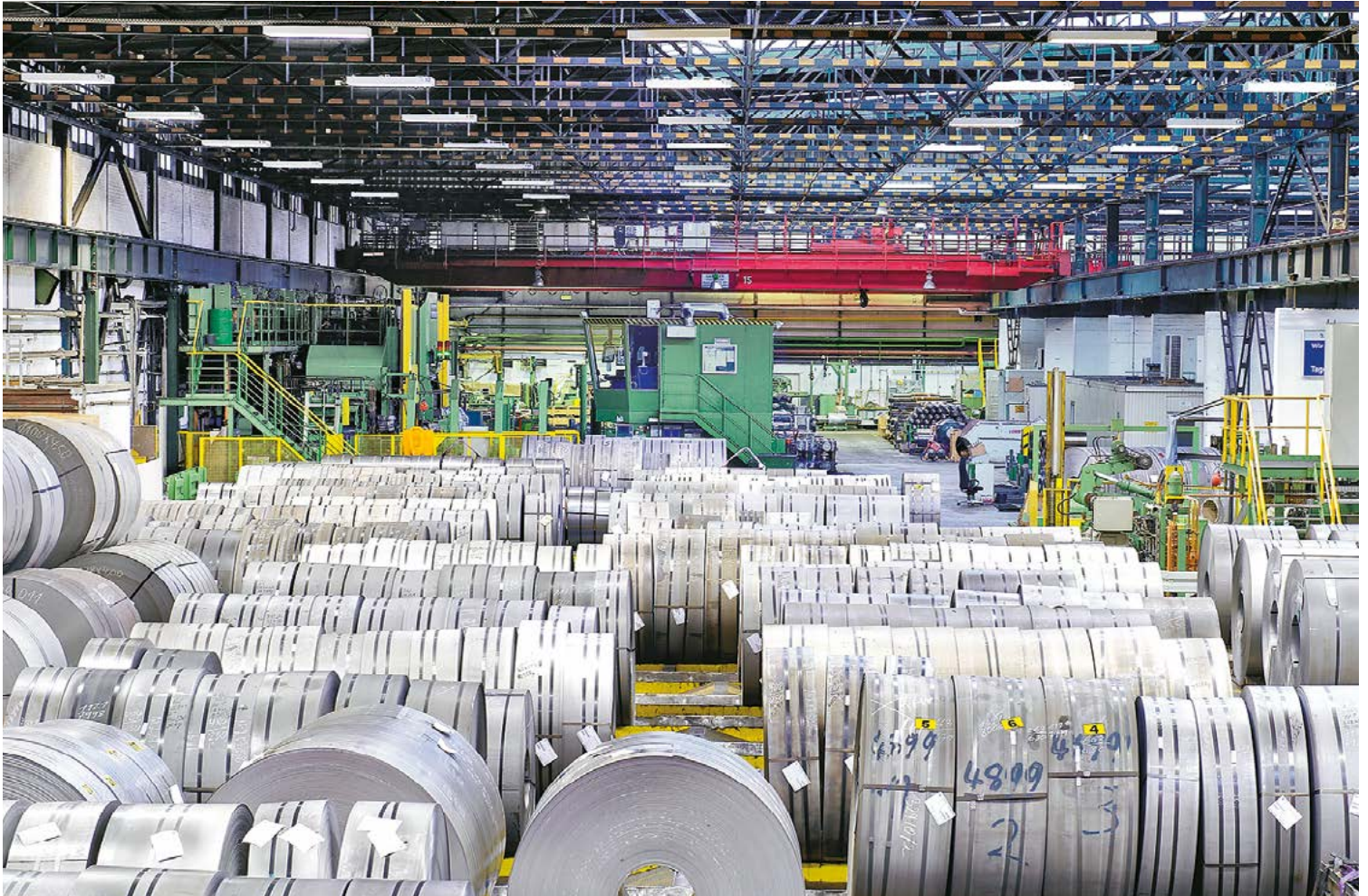
Risse + Wilke Kaltband GmbH & Co., Iserlohn | DE Lichtlösung: Gleichmäßiges und zeitweise reduziertes Beleuchtungsniveau mit der Hallenreflektorleuchte VALUEA, gedimmt mit dem Lichtmanagementsystem DIMLITE
