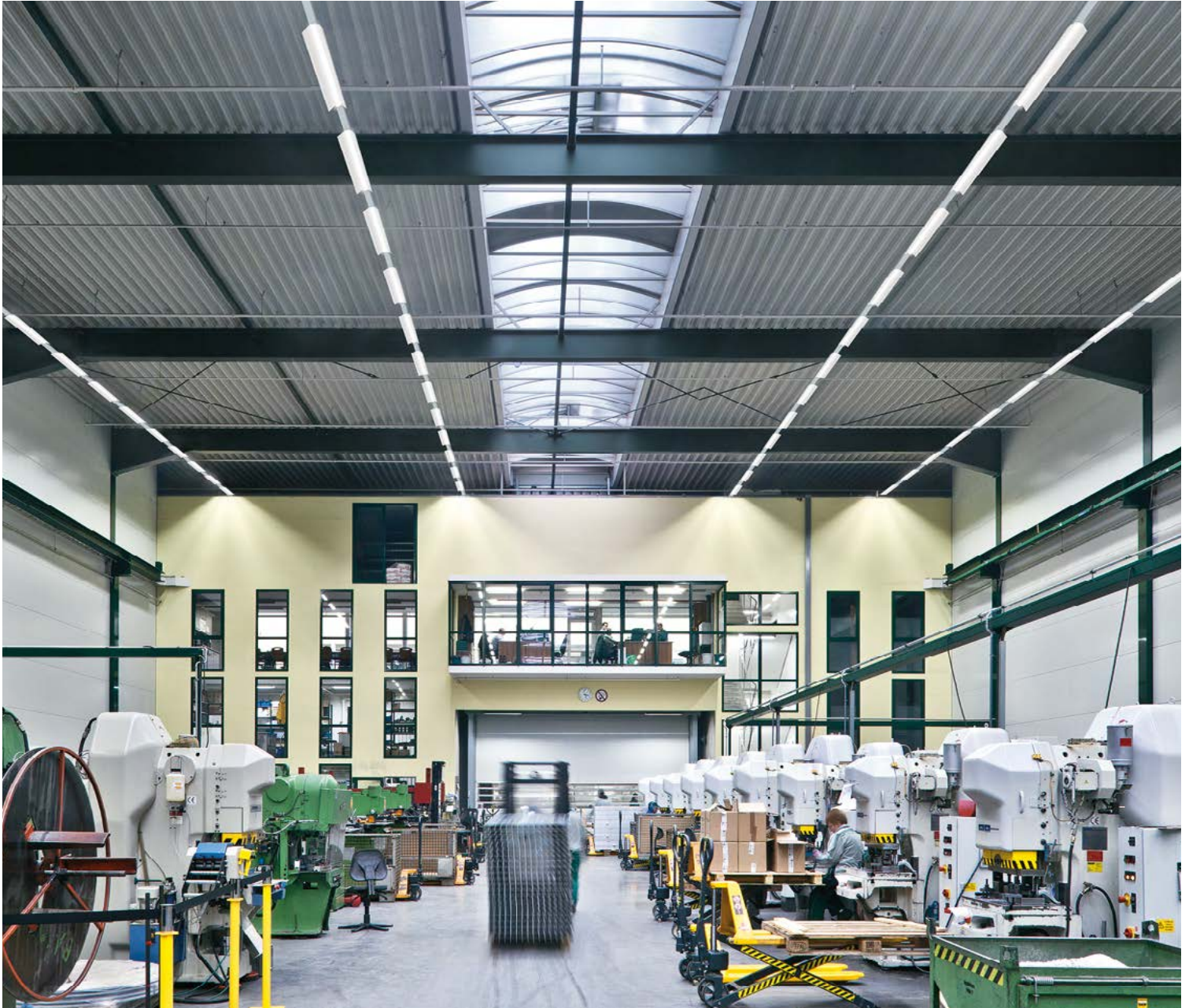
Schletter Leichtmetallbau GmbH, Kirchdorf | DE Lichtplaner: Elektro Seidinger GmbH, Bachmehring | DE Lichtlösung: Transparenz vom Büro bis in die Fertigungshalle – die Lichtbandleuchte TECTON und ihre ausgeglichenen Helligkeitsniveaus verwandeln die Idee in eine überzeugende Lösung.
