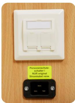
Mit einem zentralen Stromanschluss und 2xRJ 45 Anschläßen lässt sich das EduCenter problemlos in das vorhandene Netzwerk integrieren.
